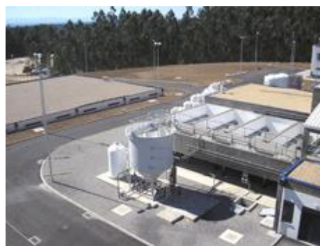
Figura 3.10. Vista parcial da Estação de Tratamento de Água.
