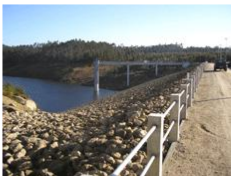
Figura 3.9. Vista Parcial da Barragem da Ribeira do Paúl.
